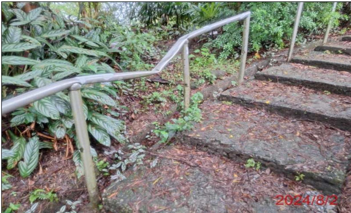
圖九 損壞的欄杆設施
