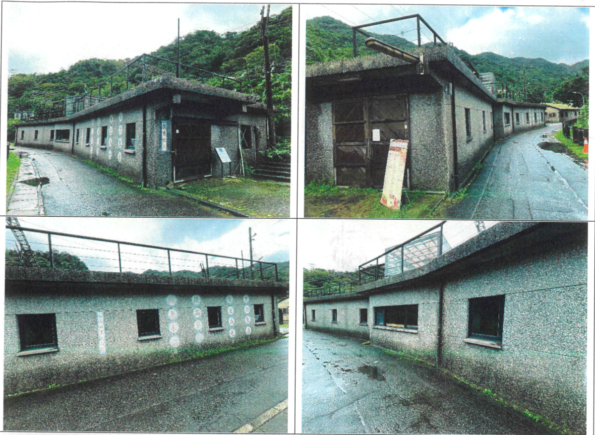
柴油機車庫外觀照片
