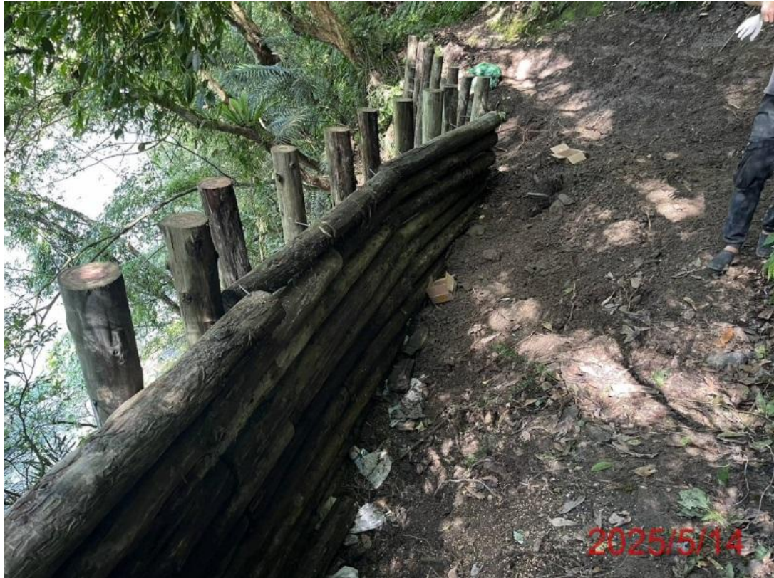
圖九 闊瀨古道-邊坡設施(新設木樁駁坎)
