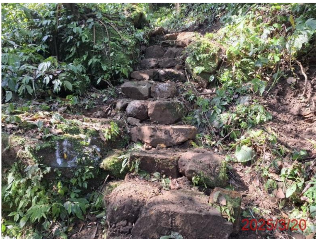
圖十一 紫微環山步道-階梯設施(新設砌石階梯)
