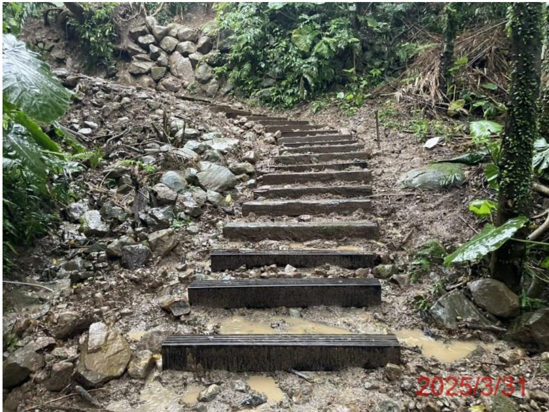
圖七 大路崁步道-階梯設施(既有木作階梯拆除運棄新設木作階梯)
