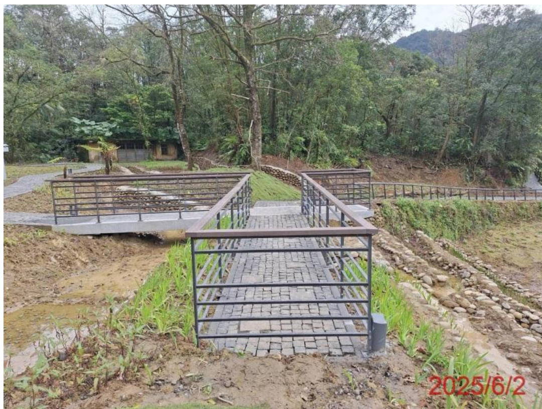
圖十八 平溪步道-欄杆設施(新設扶手欄杆)
