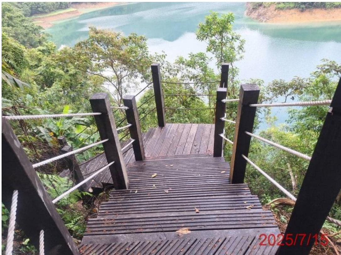
圖十六 永安步道-欄杆設施(新設特多龍繩索 \phi=18\text{mm} )
