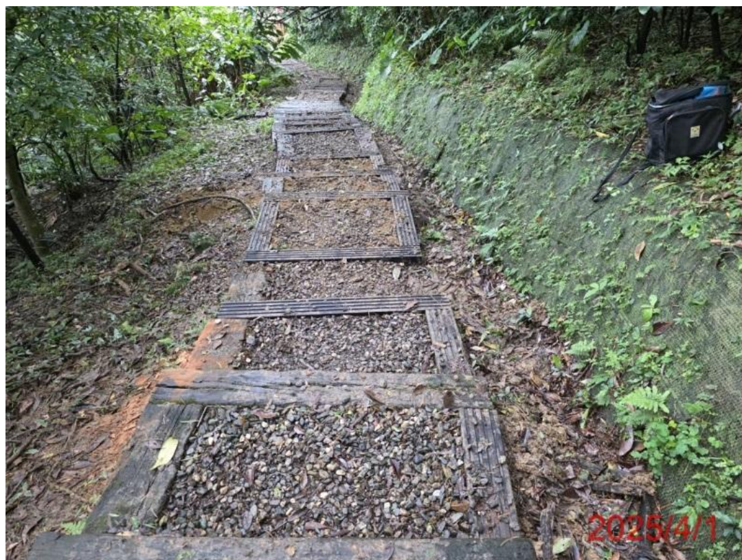
圖六 野柳里步道-階梯設施 (既有木作格框階梯木料更換)
