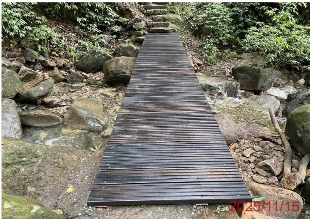
圖二十二 小粗坑步道-跨越橋
