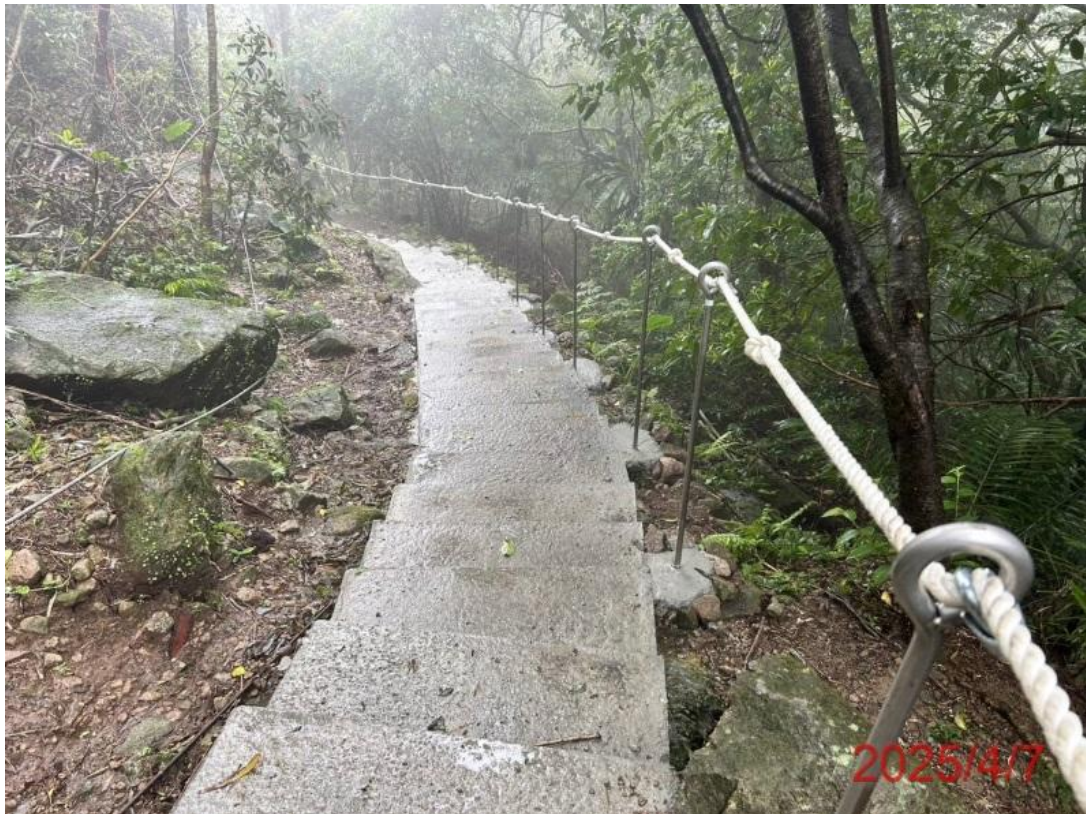
圖十五 楓樹湖小天梯步道-欄杆設施(新設長鐵環欄杆 Type B(柱體)及新設特多龍繩索 \phi=18\text{mm} )
