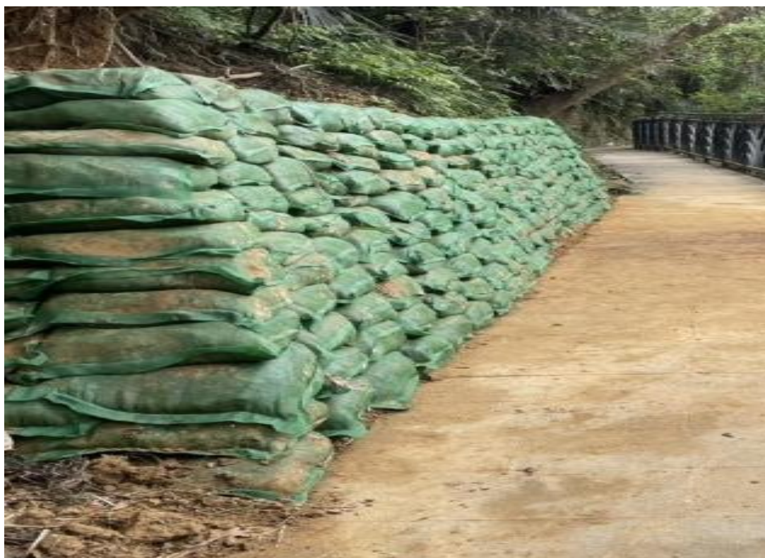
圖十二 和美山步道-邊坡設施(新設抗沖蝕網袋擋土設施)
