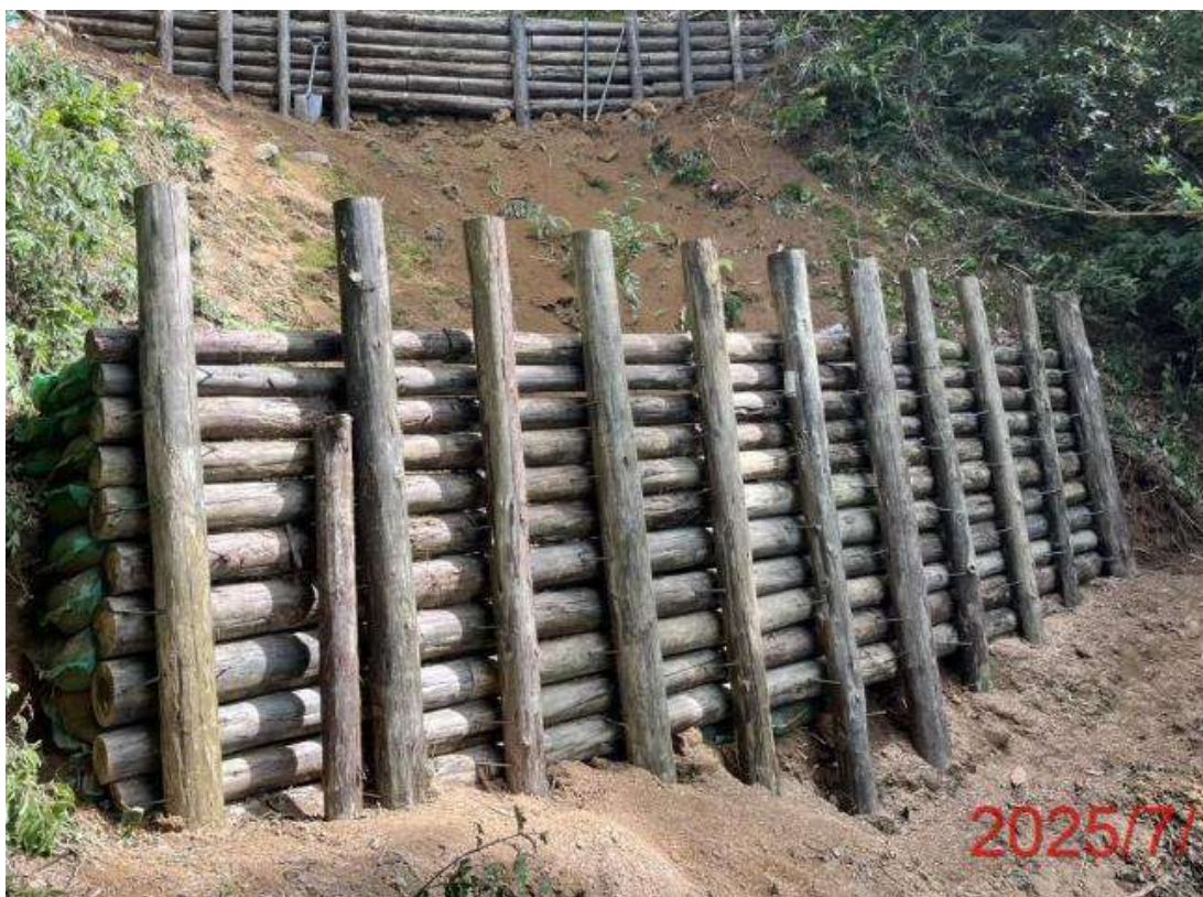
圖十三 金字碑古道-邊坡設施(新設木樁駁坎)
