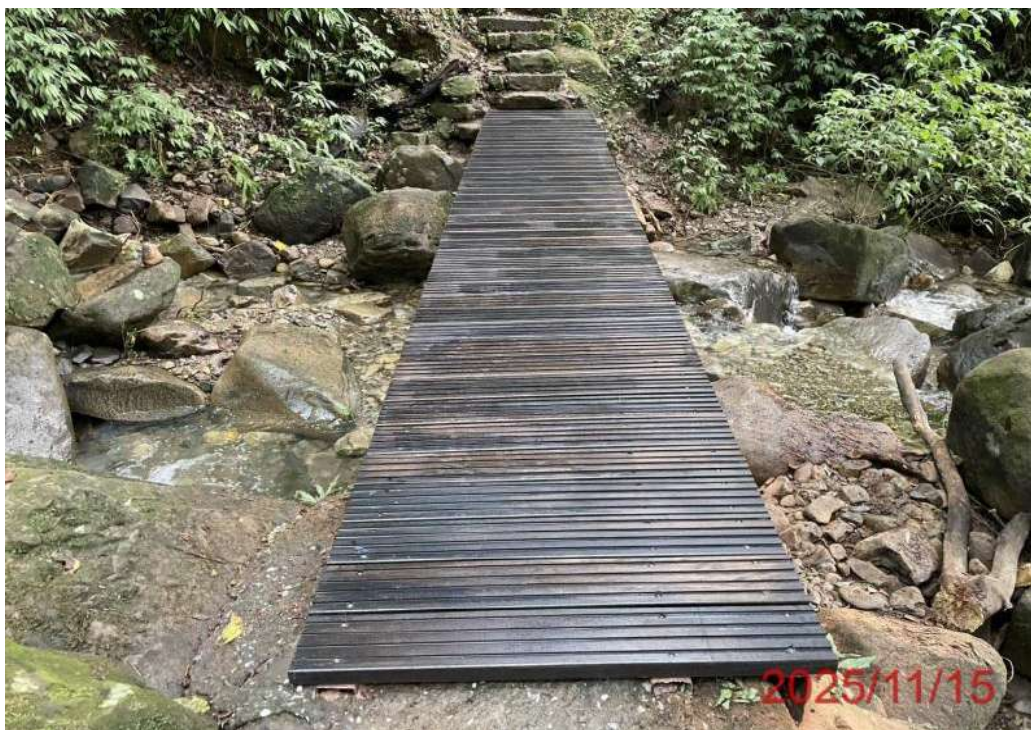
圖二十二 小粗坑步道-跨越橋
