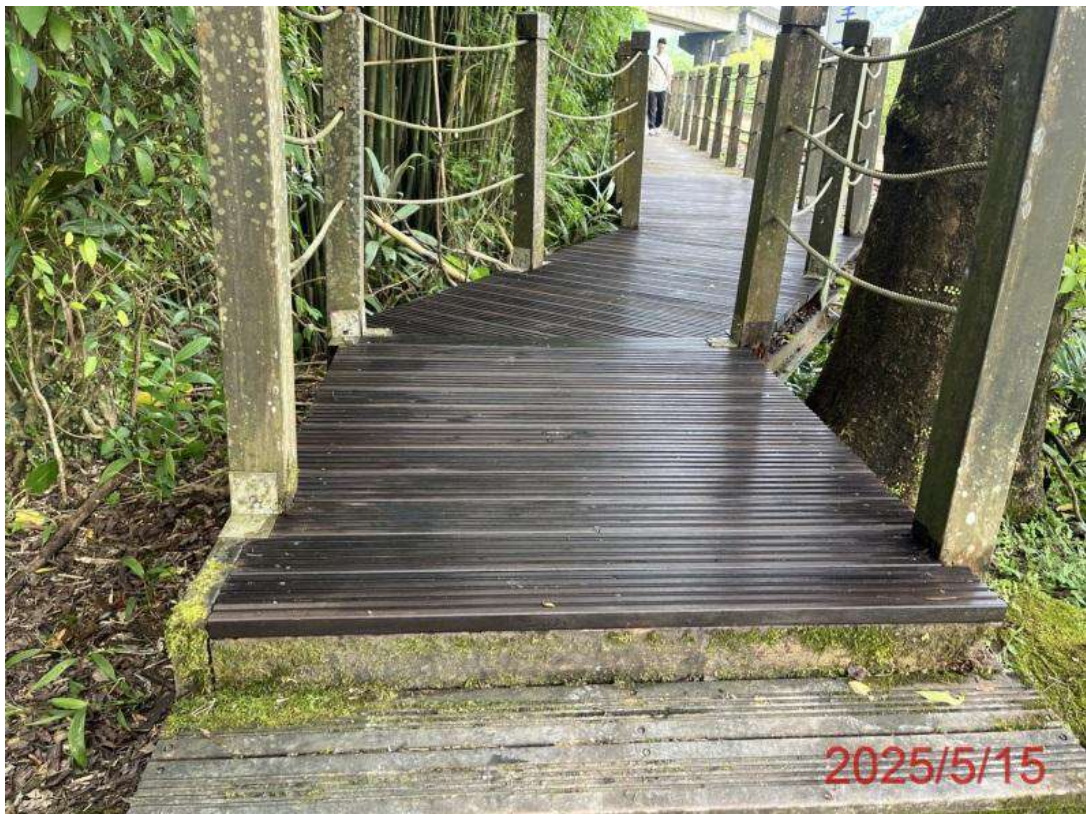
圖二十 望古瀑布步道-觀景平台(既有木棧道面板拆除運棄新設木棧道面板)
