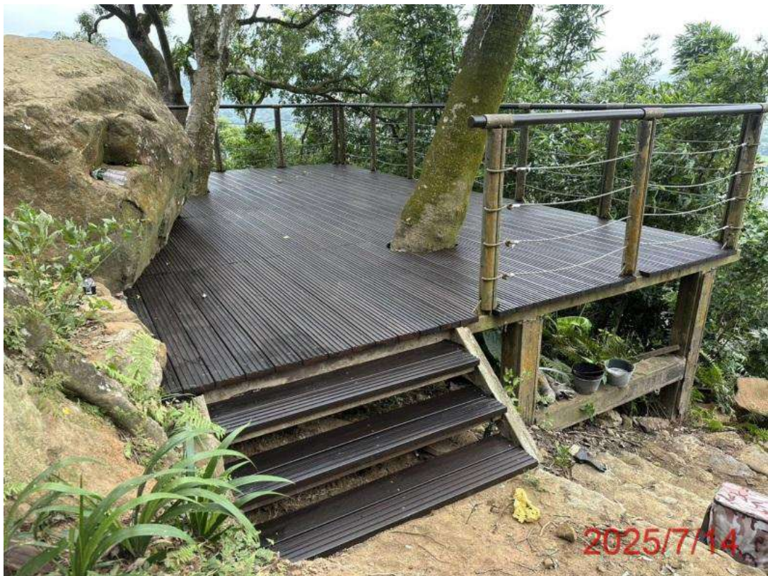
圖八 獅頭山步道-觀景平台(既有觀景平台面板及欄杆扶手更換)
