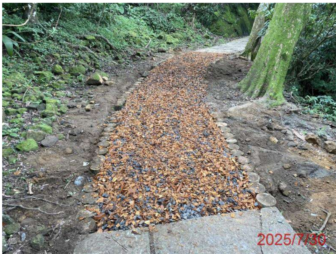
圖十四 琉榔路步道-鋪面設施(新設碎石加木屑鋪面)
